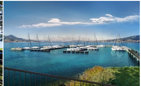
Bsp. Hafenerneuerung Lachen
